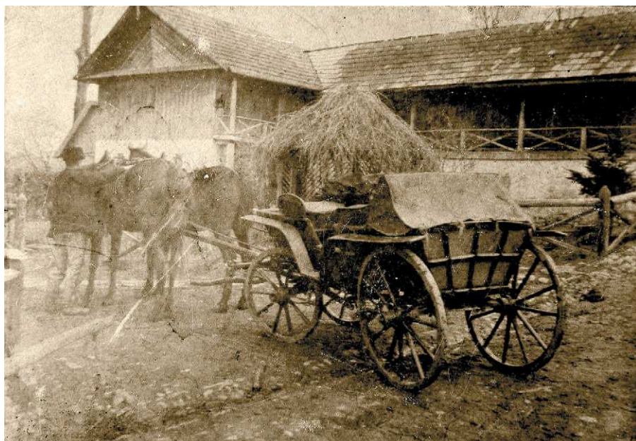
Fot. 3. Widok wozowni przy Starym Dworze, przed przebudową w 1935 r., lata 20–30. XX w.?, autor nieznany (archiwum K. Górskiej)
