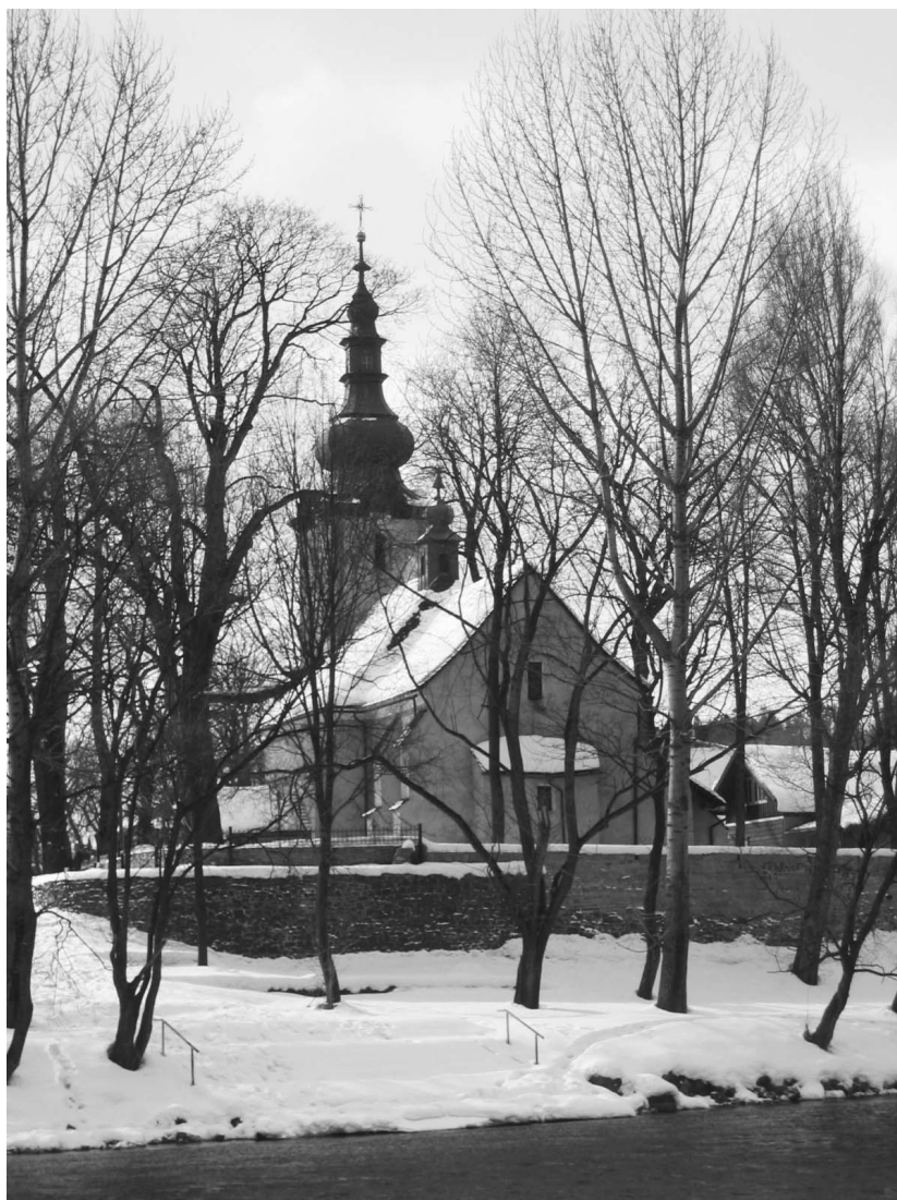
Fot. 5. Kościół p.w. Wszystkich Świętych w Krościenku n/D. (Fot. A. Siwek) Church of All Saints in Krościenko. (Phot. A. Siwek)
