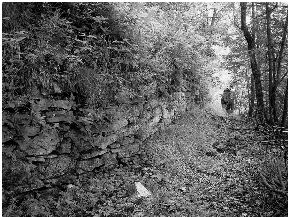
Fot. 5. Dalszy, zarośnięty odcinek muru tarczowego – lico zewnętrzne. Stan w lipcu 2004 r. (Fot. P. Stępień) Further part of the shield wall, overgrown with plants – outer side. Condition in July 2004. (Photo P. Stępień)
