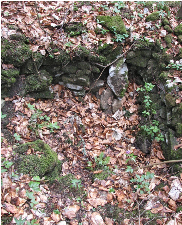
Fot. 1. Kamienny fundament odkryty w trakcie badań powierzchniowych (fot. M. Wawrzczak)
