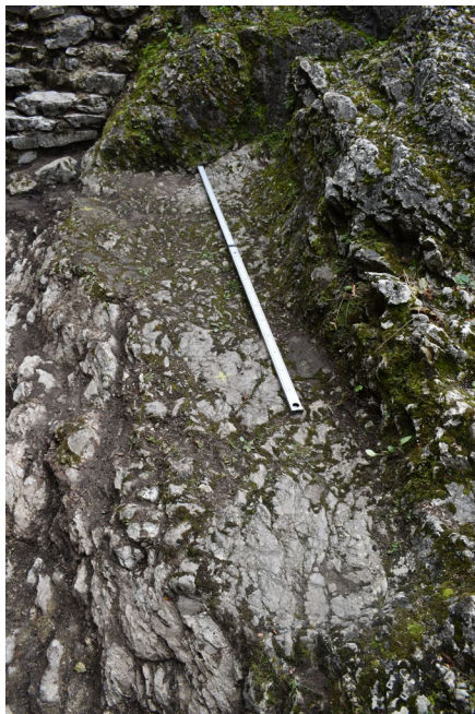
Fot. 12. Podkucia skały nad piwnicą, po stronie północnej (fot. P. Kocańda)
