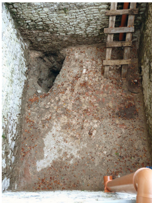
Fot. 1. Dno tzw. cysterny, widoczna posadzka oraz w narożniku studnia (fot. K. Karwowski)
