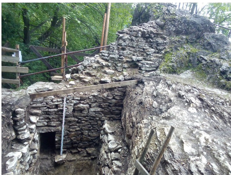
Fot. 4. Zachodni mur tarczowy, zachodnia część piwnicy (fot. D. Gazda)
