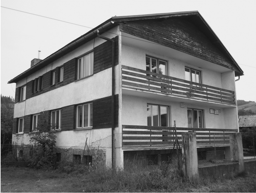
Fot. 3. Objekt Správy PIENAP-u v súčasnosti. The Pieniny National Park building office today.
